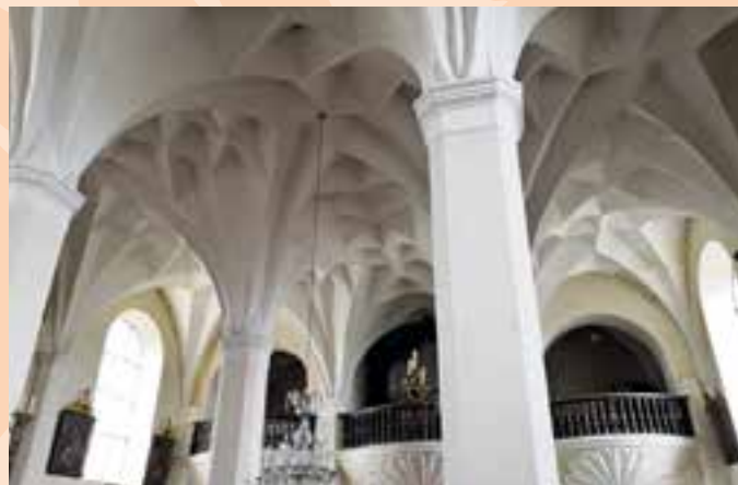
Sklípková klenba v kostele Nanebevzetí Panny Marie v Nezamyslicích
